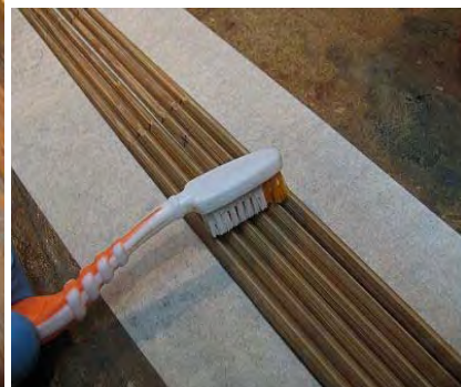
Stendere la colla uniformemente
