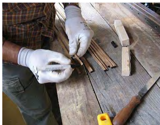
Marcare la superficie di taglio con un pennarello
