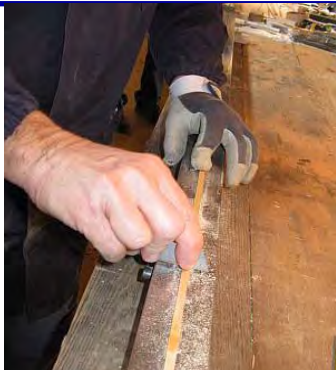
Rimozione smalto con una lama da cutter o da pialla
